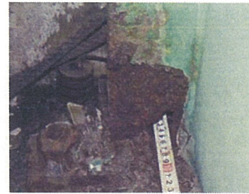
桁の腐食
